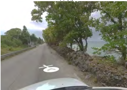
礫+防潮林の堤防(護岸) 南部外洋側
