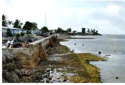
埋立して直立護岸を築造 Uliga地区 外洋側
