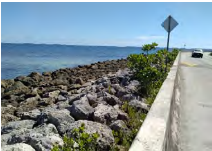
埋立地の前面護岸 空港北 ラグーン側
